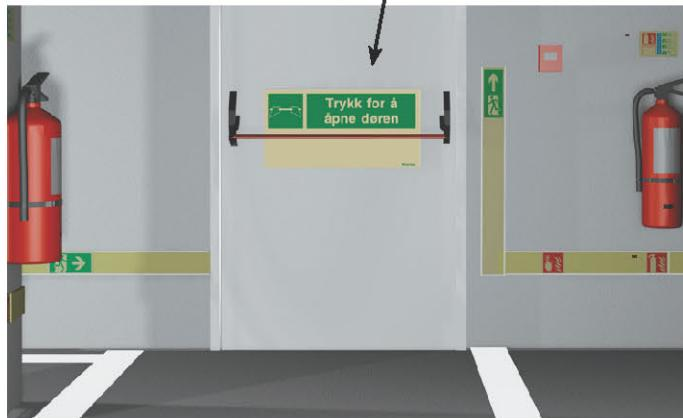
Nødutgang [åpnes på høyre side] med skilt og markeringstripes montert på en skinne som beskytter mot hærverk.
